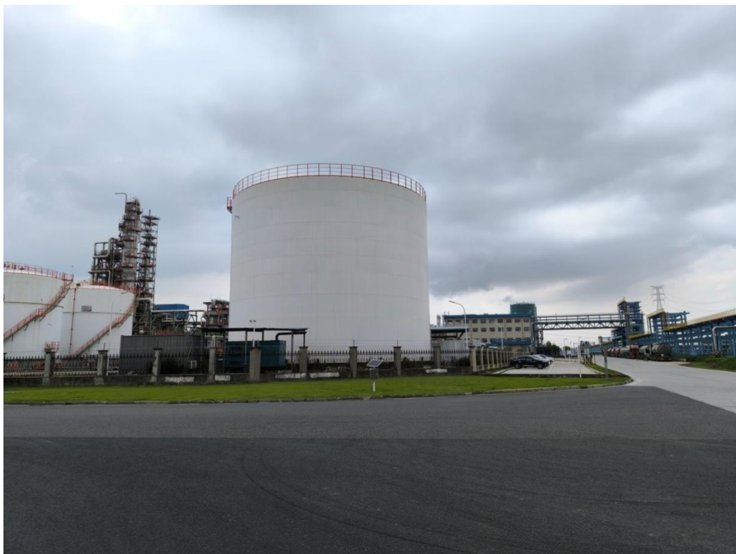
建西侧博汇化工
