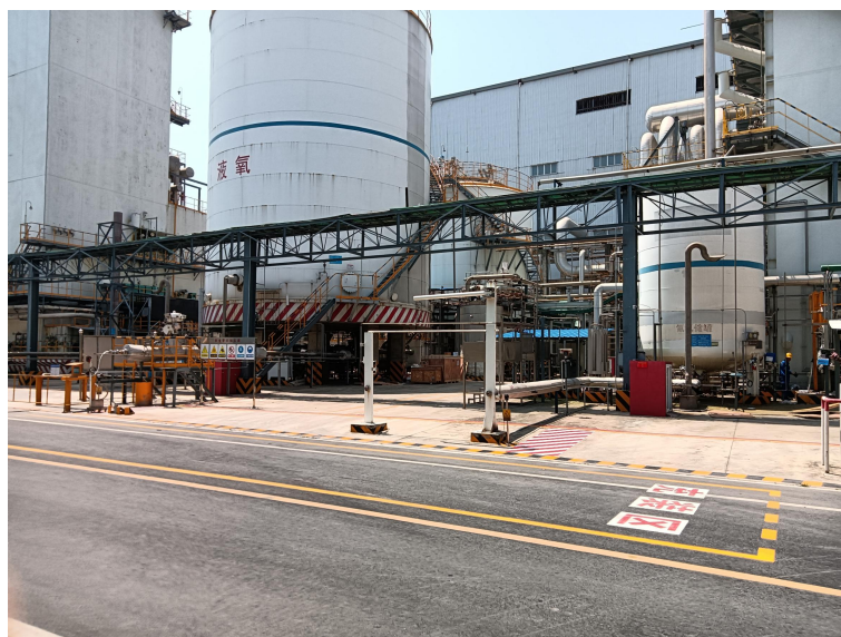
图 2.4-6 项目南侧消防道路及空分装置区
