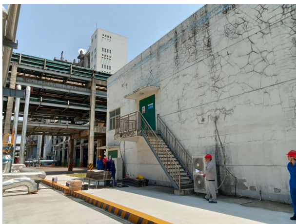
项目东侧气化变电所
