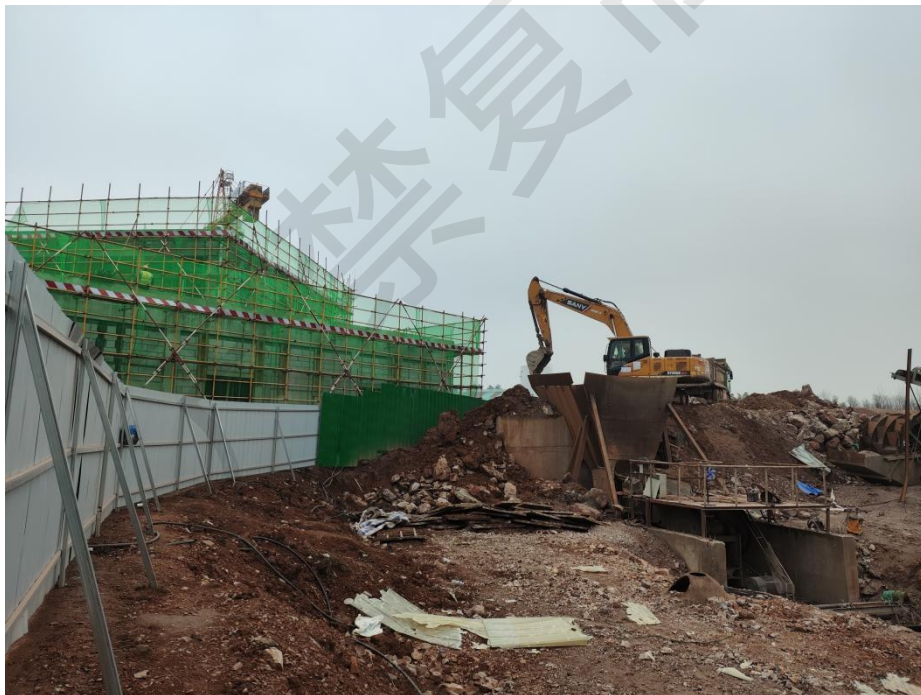
图 1.3 项目西北侧服务区综合办公楼
