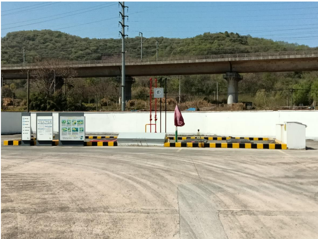
图6 项目西侧宁安高速铁路及一条架空电力线
