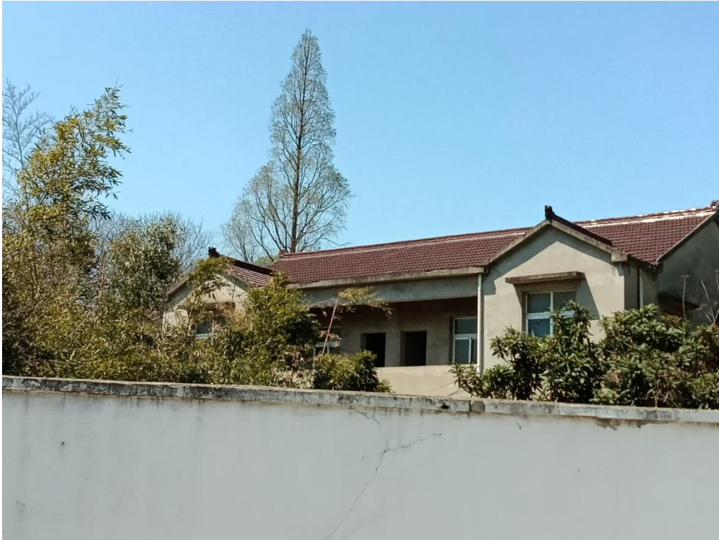
图5 项目南侧1座1层民宅和1座2层民宅
