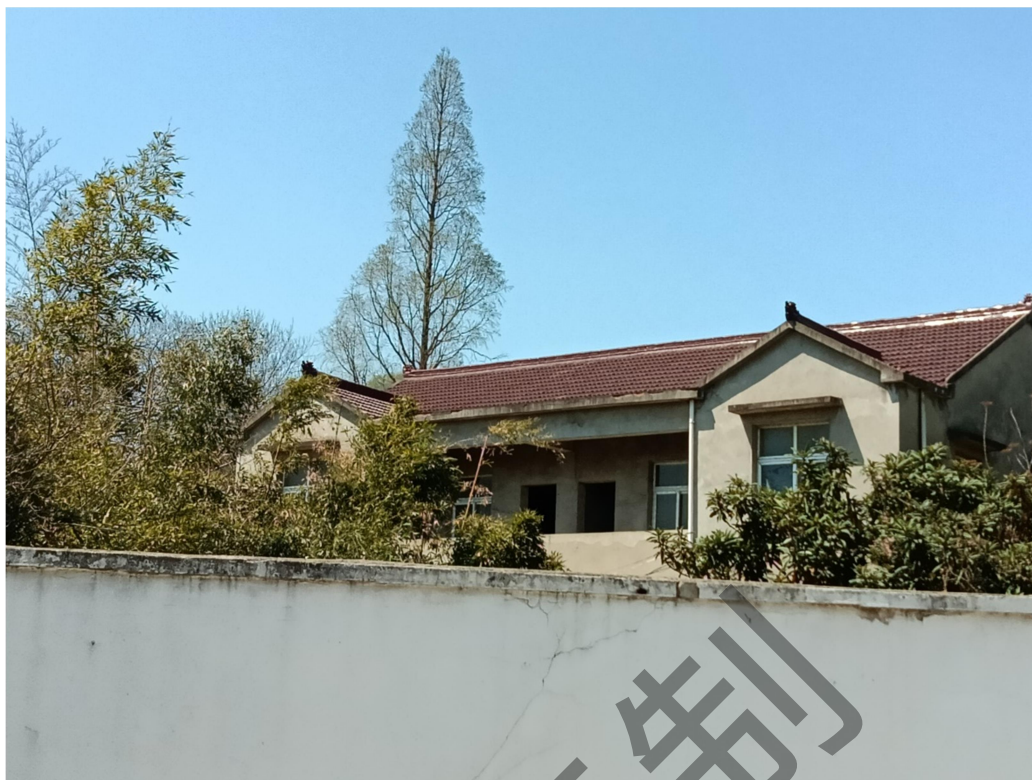
图 2-9 加油站南侧为 1 座 1 层民宅和 1 座 2 层民宅
