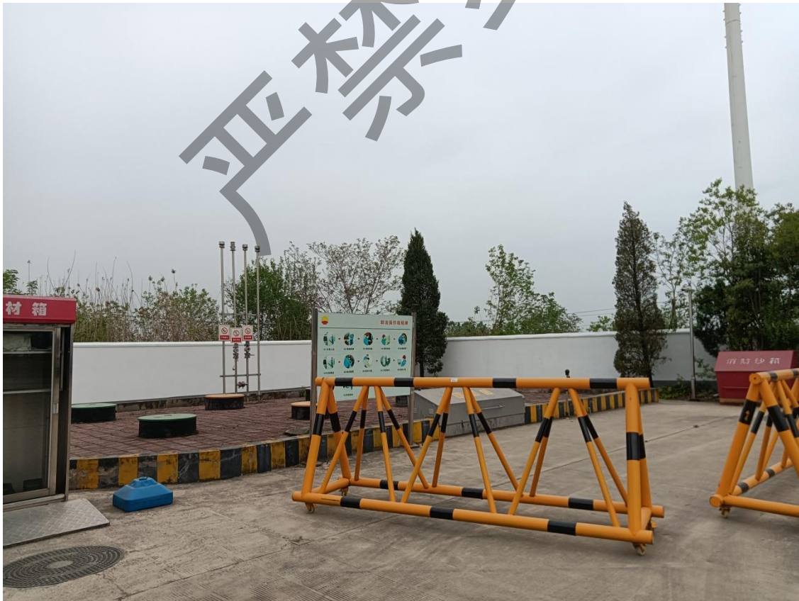
加油站罐区照片
