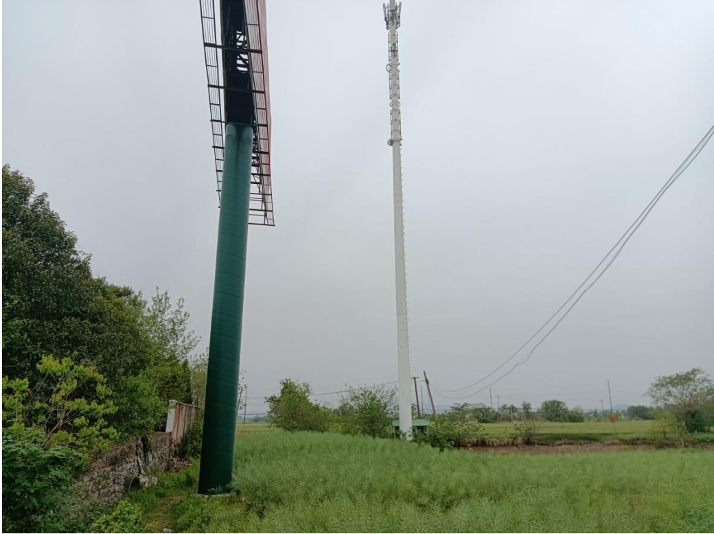
图 7 项目北侧架空电力线路、架空通信线路和通信发射塔
