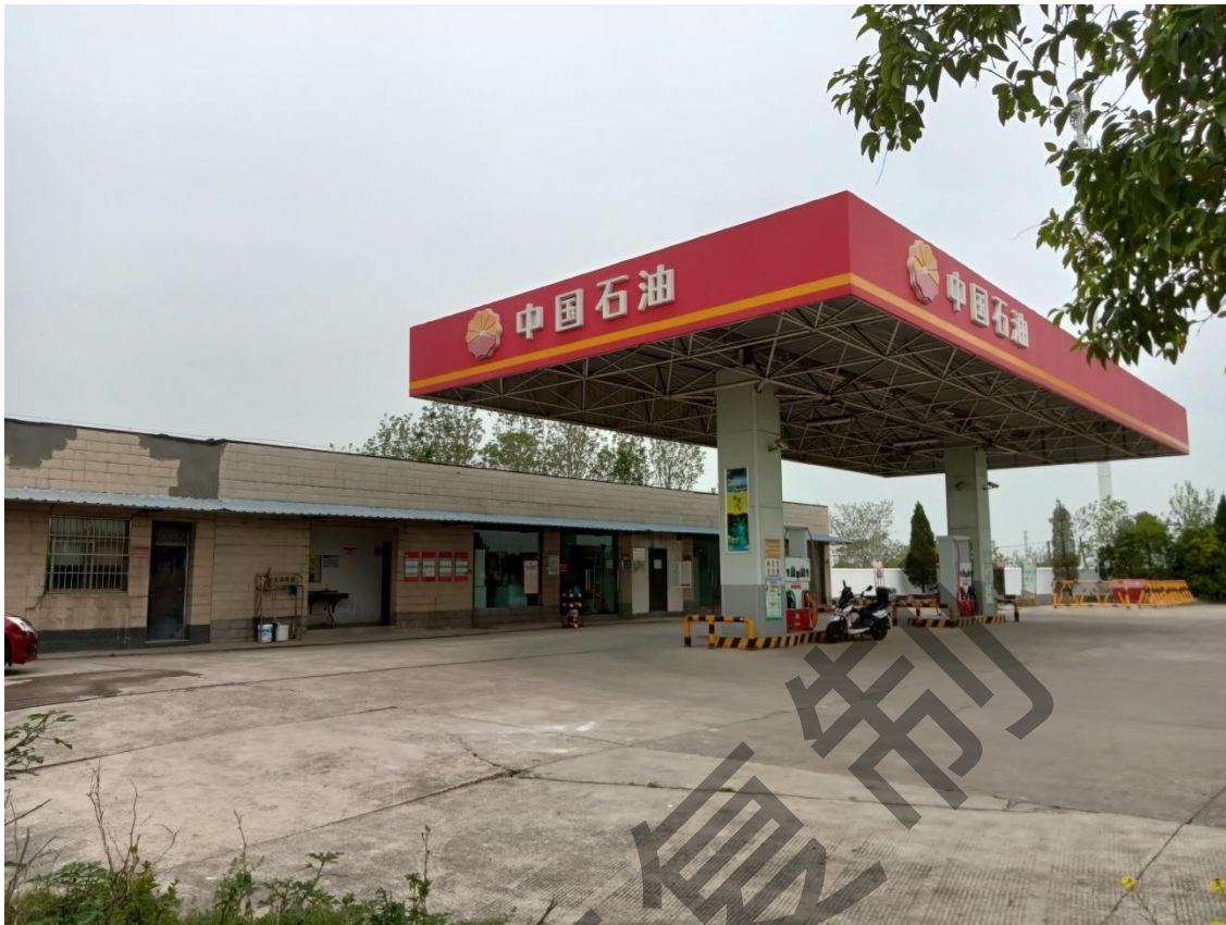
加油站全景照片
