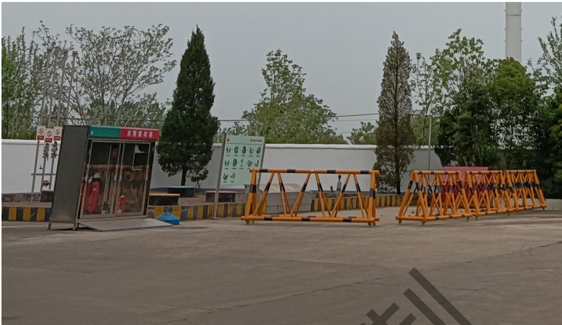
图 2-12 消防器材箱和消防沙箱
