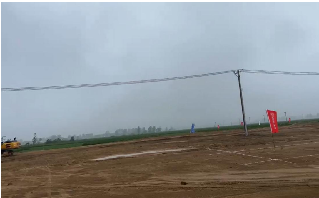
图 1-3 项目南侧为空地（拟拆电线杆，现已切断）
