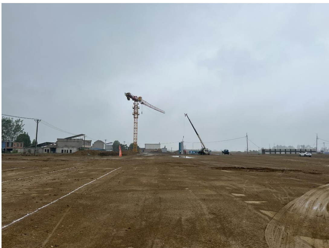
图 1-4 项目西侧为漆园服务区场地（拟拆迁民居，现已无人居住）
