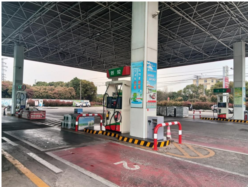
图 2-11 加油站加油区照片
