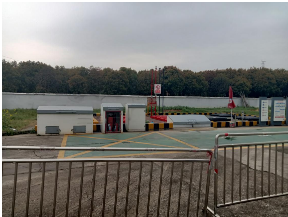
图 2-13 加油站储罐区照片
