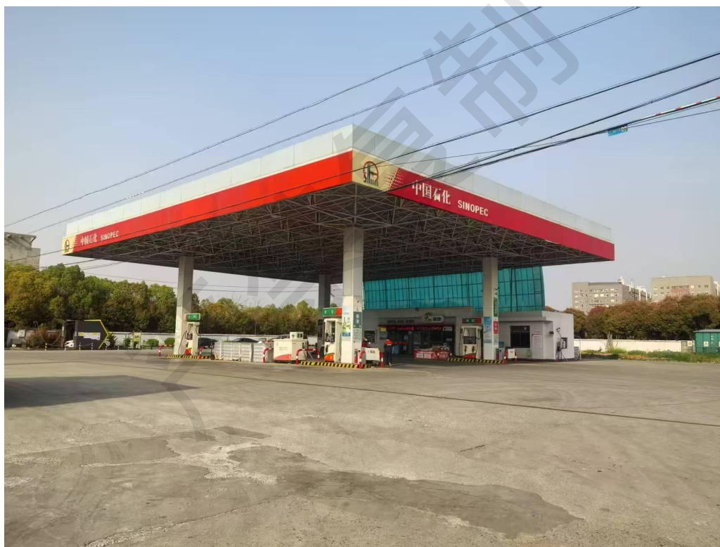
图2-10 加油站全景照片
