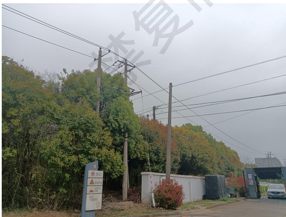
图2-9 加油站北侧树林及架空电力线路
