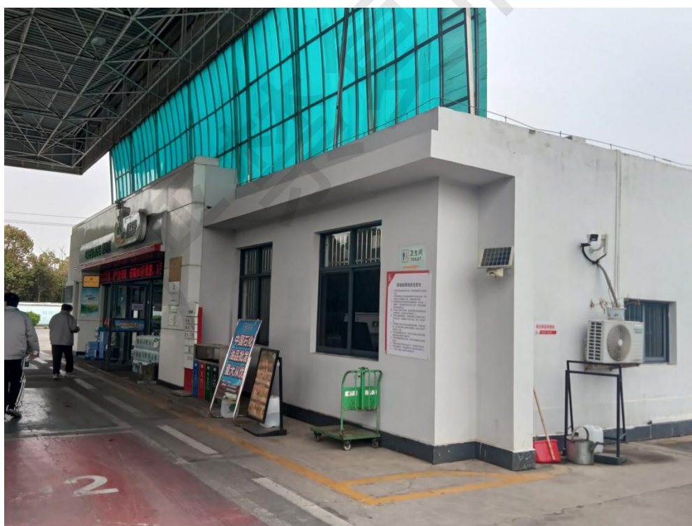
图 2-12 加油站站房照片
