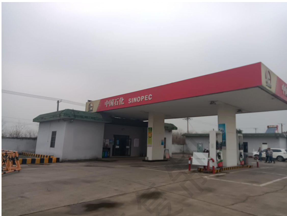
加油站全景照片
