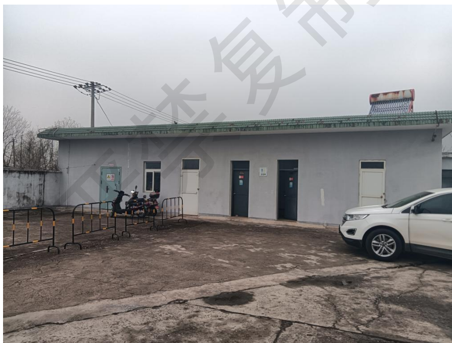
图 2-14 加油站辅助用房照片
