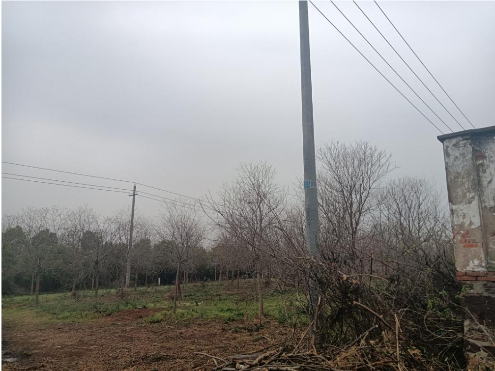
图 5 项目南侧空地及一处架空电力线路
