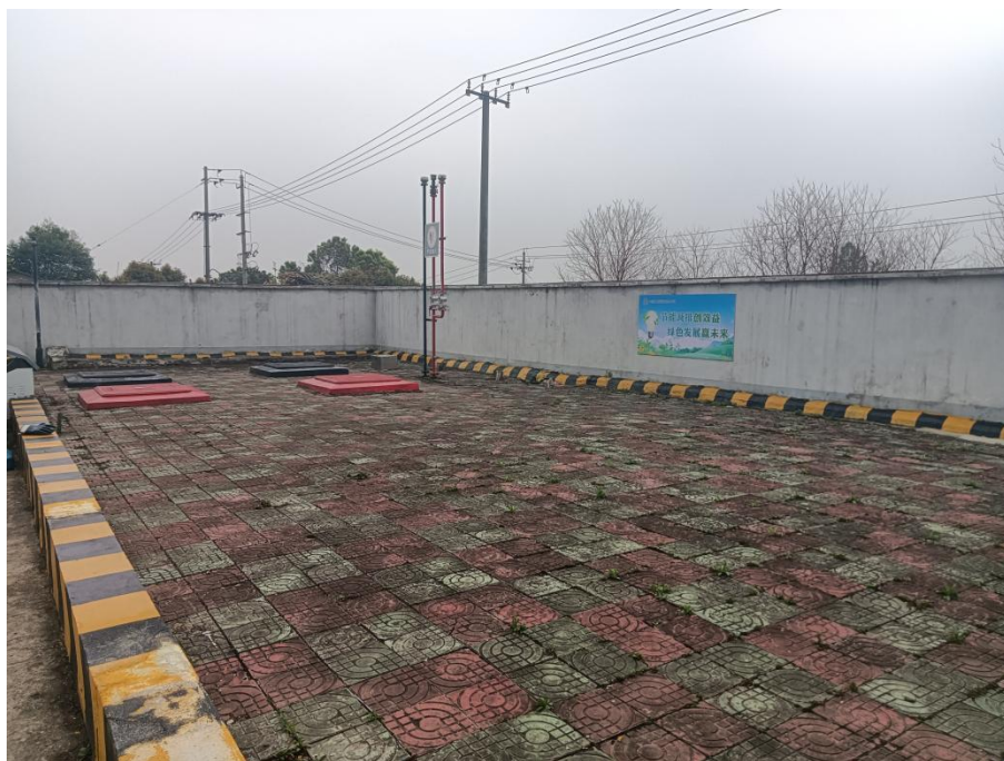
图 2-13 加油站储罐区照片
