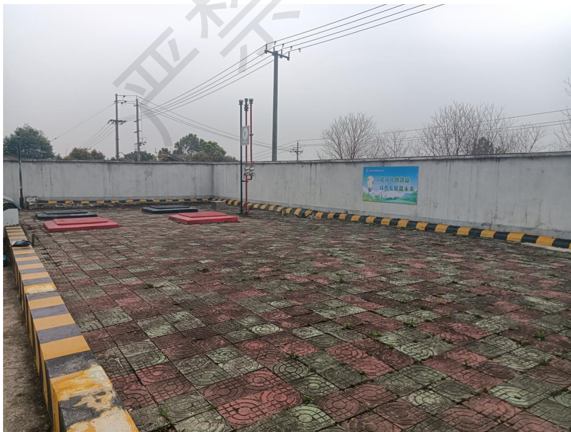
加油站罐区照片
