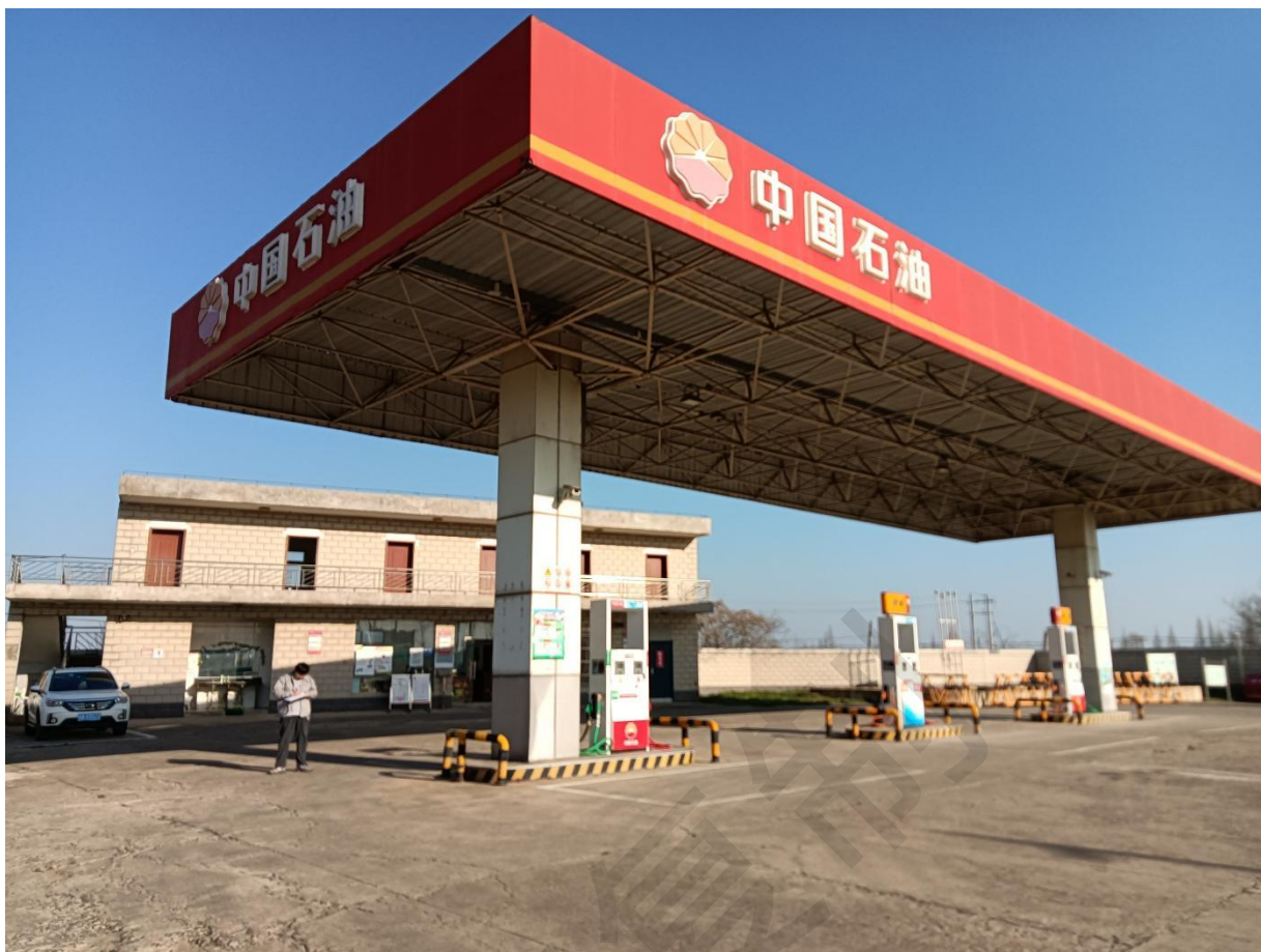
图2-9 加油站全景照片
