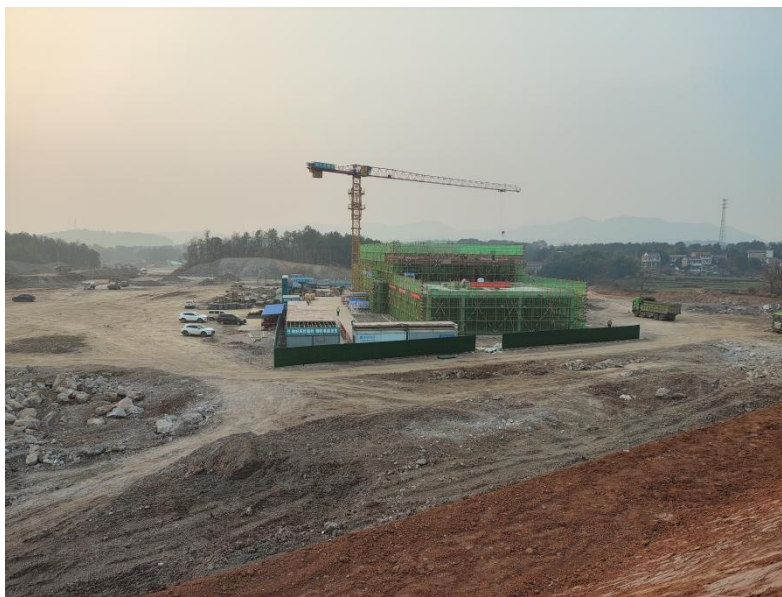
图 1.3 项目建东侧服务区场地（在建）以及服务区箱式变压器（在建）
