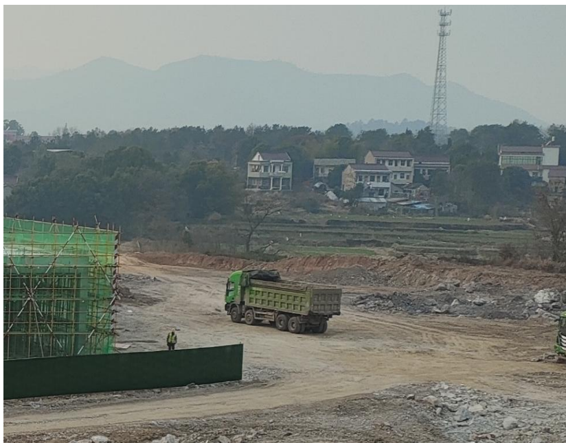
图 1.5 项目建北侧为空地，建东北侧为服务区综合楼以及停车场（在建）
