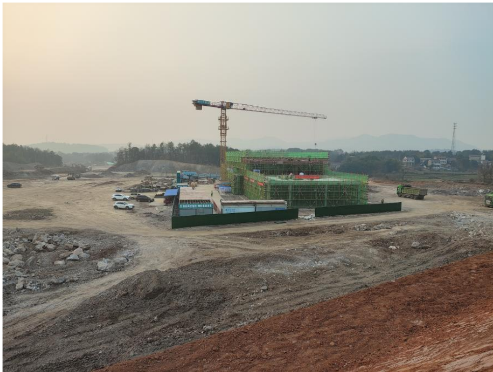
图 5 项目建东侧服务区场地（在建）以及服务区箱式变压器（在建）
