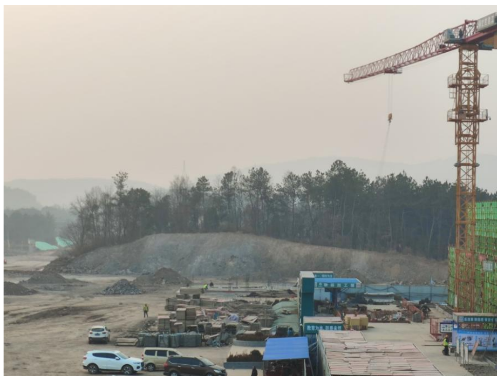
图 6 项目建西侧空地
