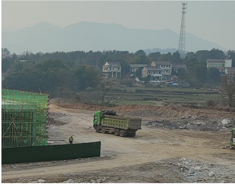
图 7 项目建北侧为空地，建东北侧为服务区综合楼以及停车场（在建）
