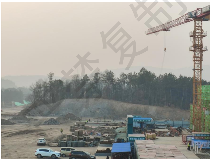
图 1.4 项目建西侧空地
