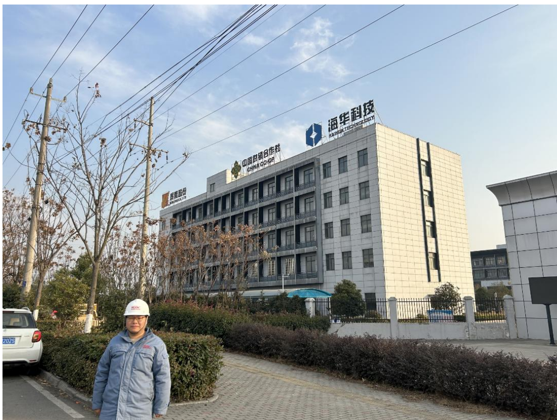
复核 人员勘察现场照片
