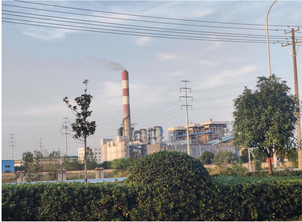
图2 东北侧为中粮生物科技股份有限公司沫河口分厂
