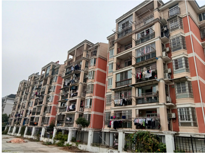
图3 加油站北侧幸福花城小区居民楼
