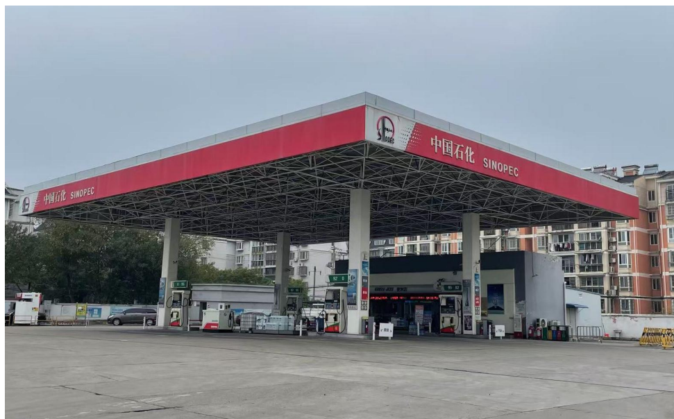
图 1 加油站全景照片
