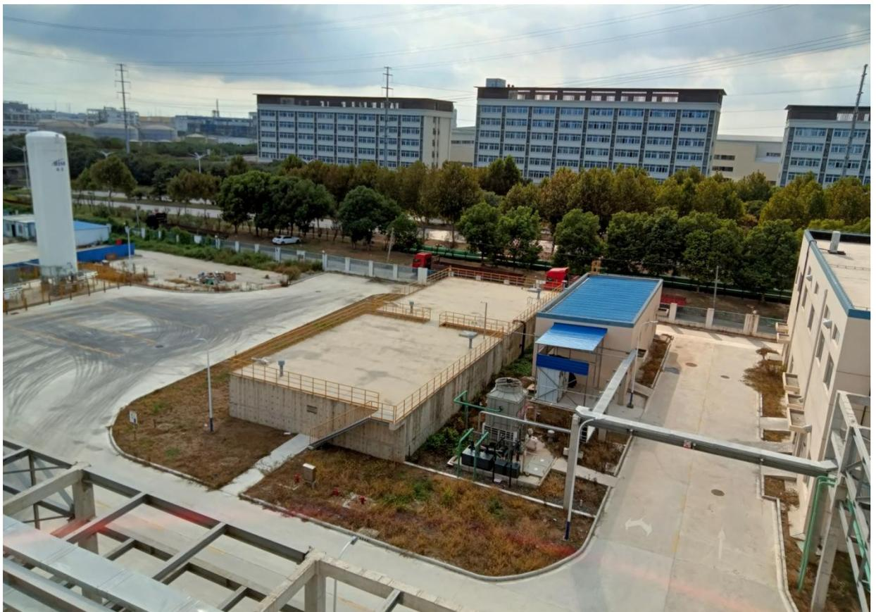
图 5 消防泵房、消防水池、循环水站
