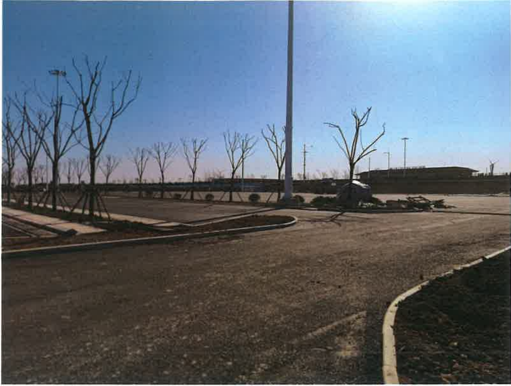
图 5 项目东侧综合楼及停车位
