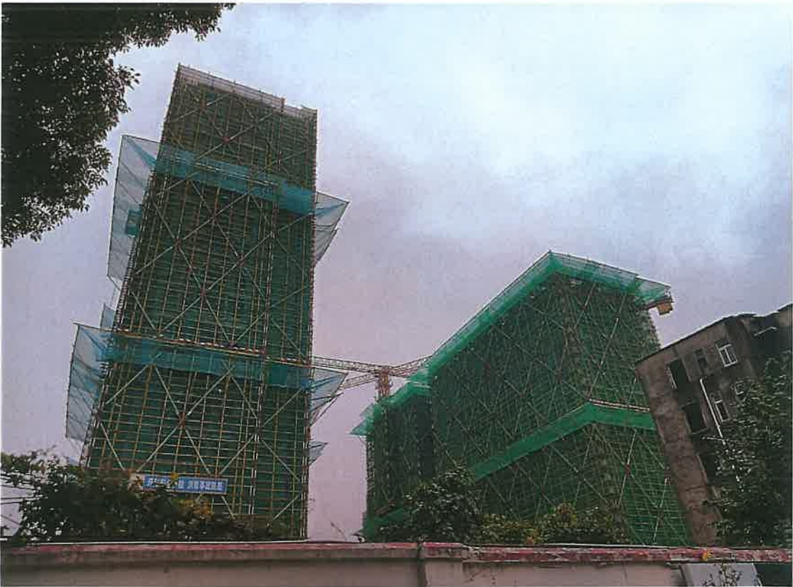
图 4 加油站东侧 2F 民房和在建小区及东南侧居民楼
