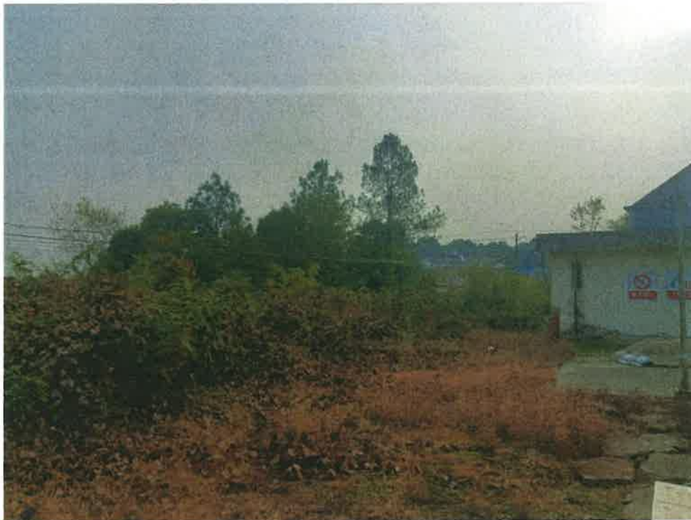
图 4 项目东侧架空通信线路
