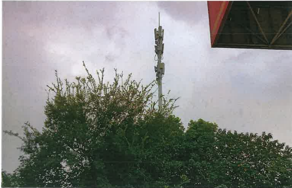
图 7 项目西南侧通信塔
