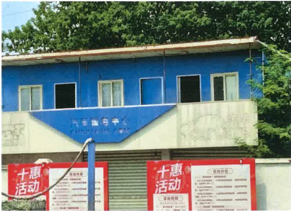
图 6 项目北侧二层闲置板房
