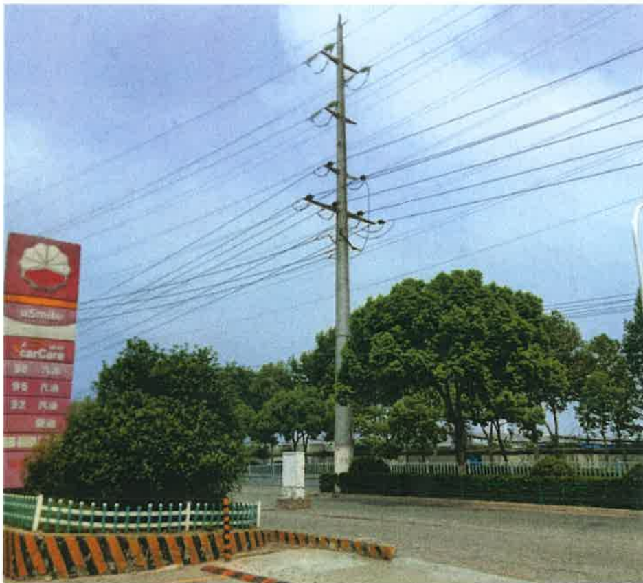
图3 项目东侧长江北路和架空电力线路
