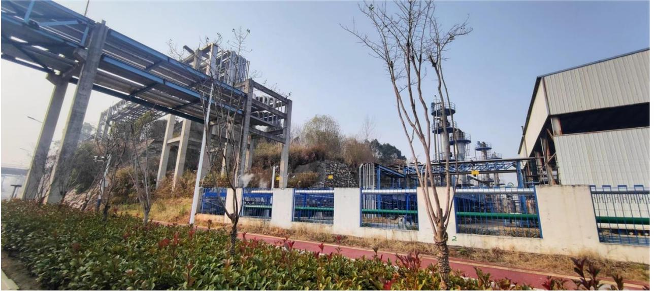
建西侧山坡及铁路工业站成品油输送管廊
