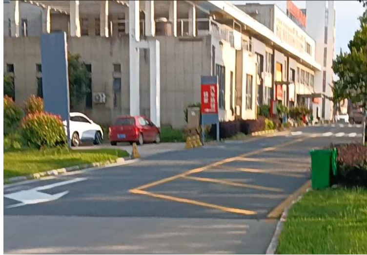
图 3 南侧小车停车位和服务区综合楼
