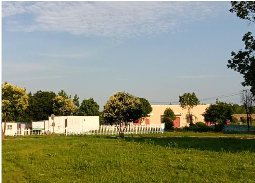
图 2 东南侧污水处理站和水泵房
