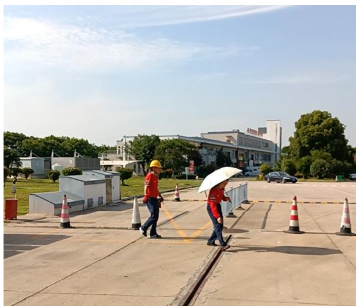
图 5 西北侧为服务区综合楼和汽车充电站
