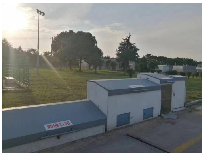
图 4 西侧架空电力线和服务区附属用房
