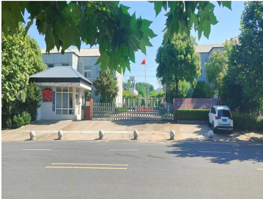
建东北侧安庆天运精细化工有限公司
