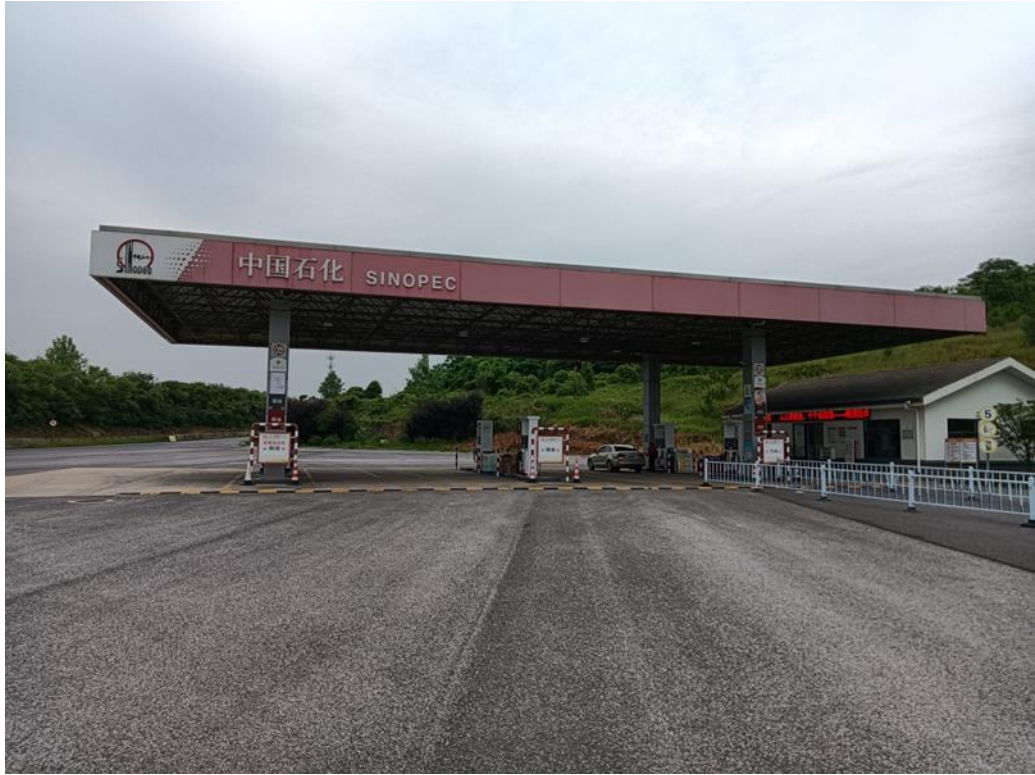
望江服务区加油站北站正面照片
