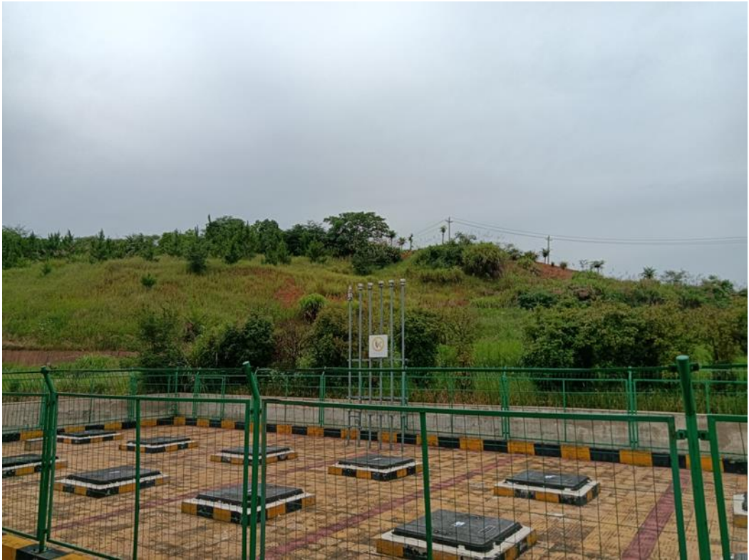
望江服务区加油站北站建北侧为山地，有架空电力线路（无绝缘层，杆高 10m）
