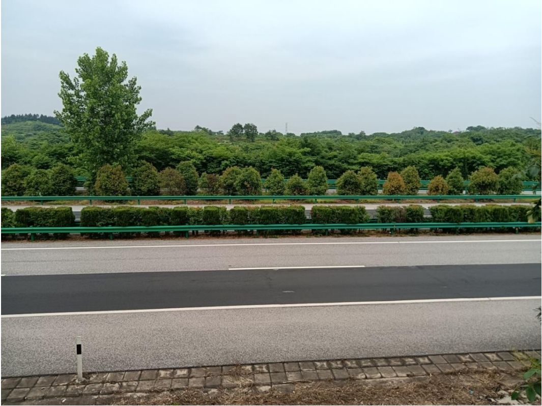
望江服务区加油站南站建北侧为 G35 济广高速
