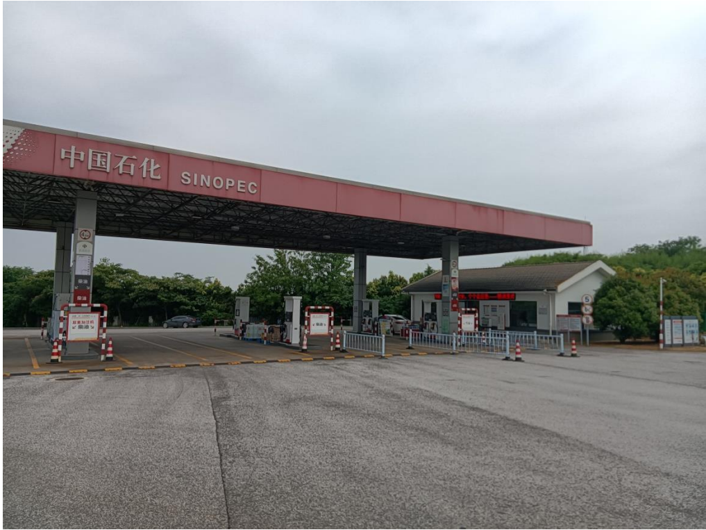
望江服务区加油站南站正面照片
