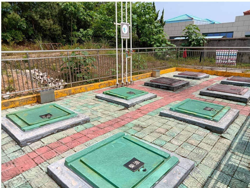
太湖服务区加油北站罐区照片
