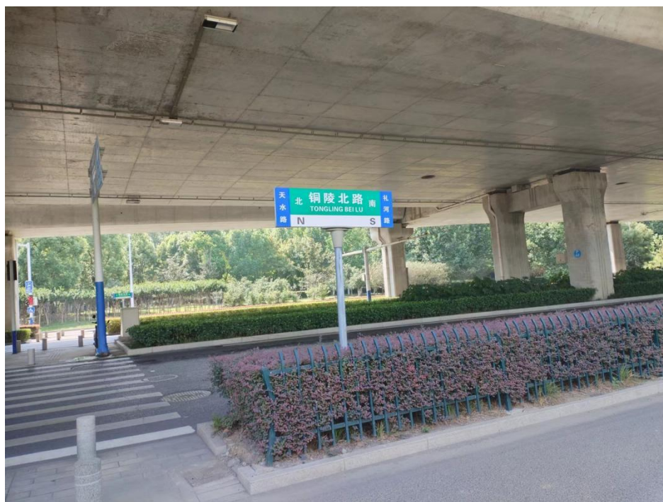
厂区东侧为铜陵北路
