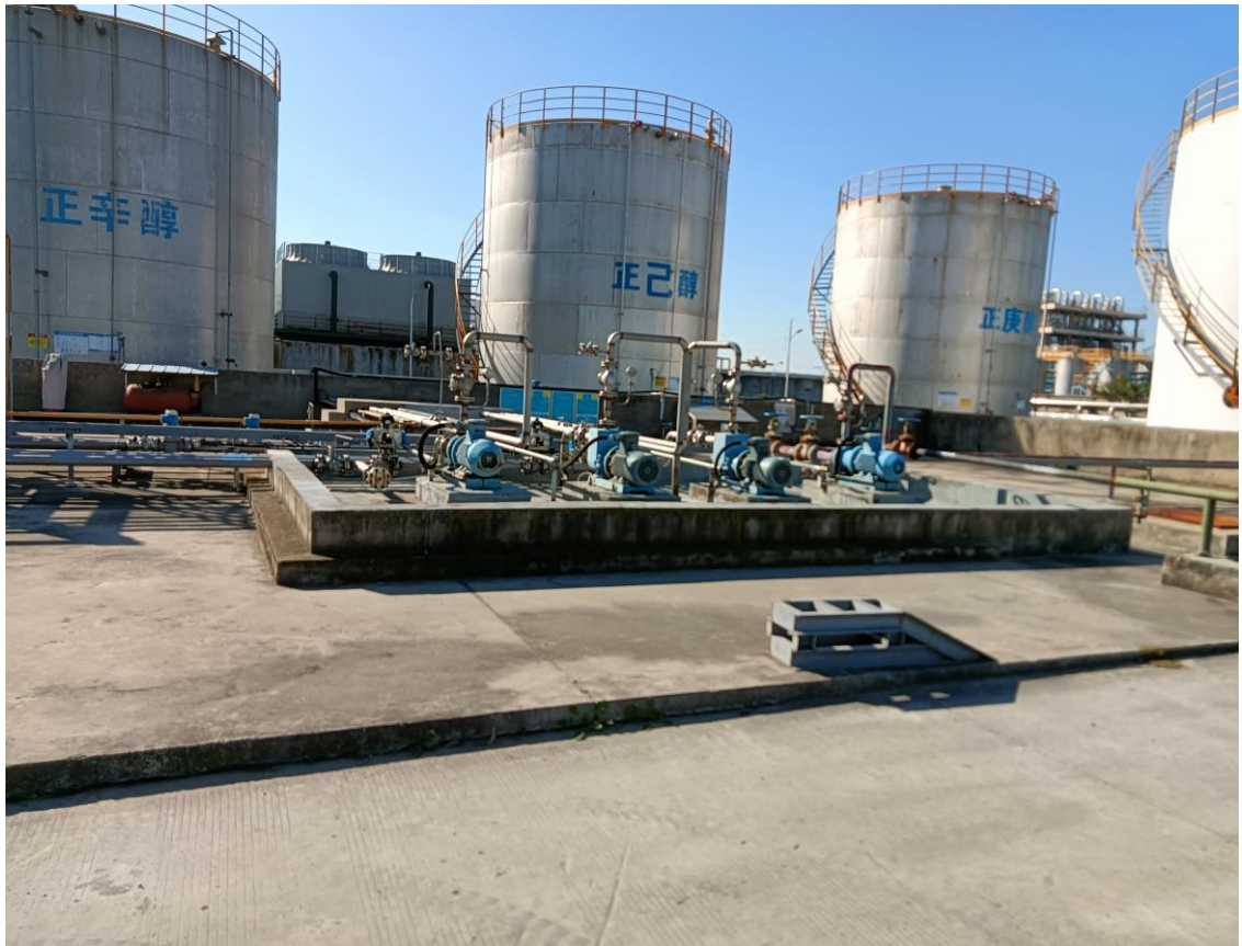
原料罐区现场照片
