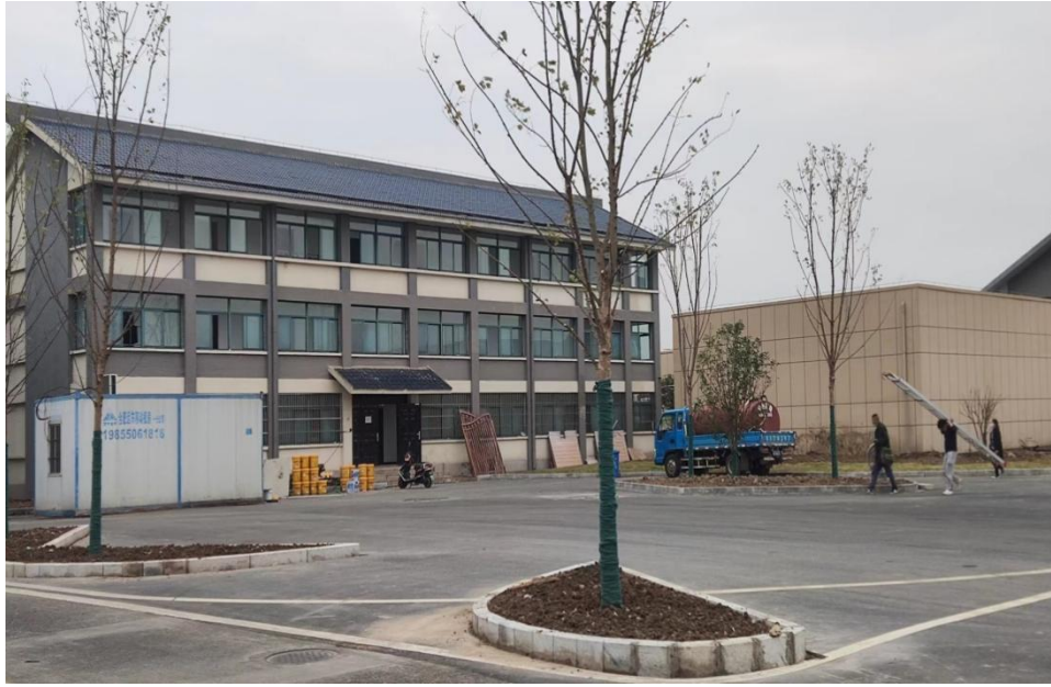
图5 西侧消防控制室和原服务区宿舍楼
