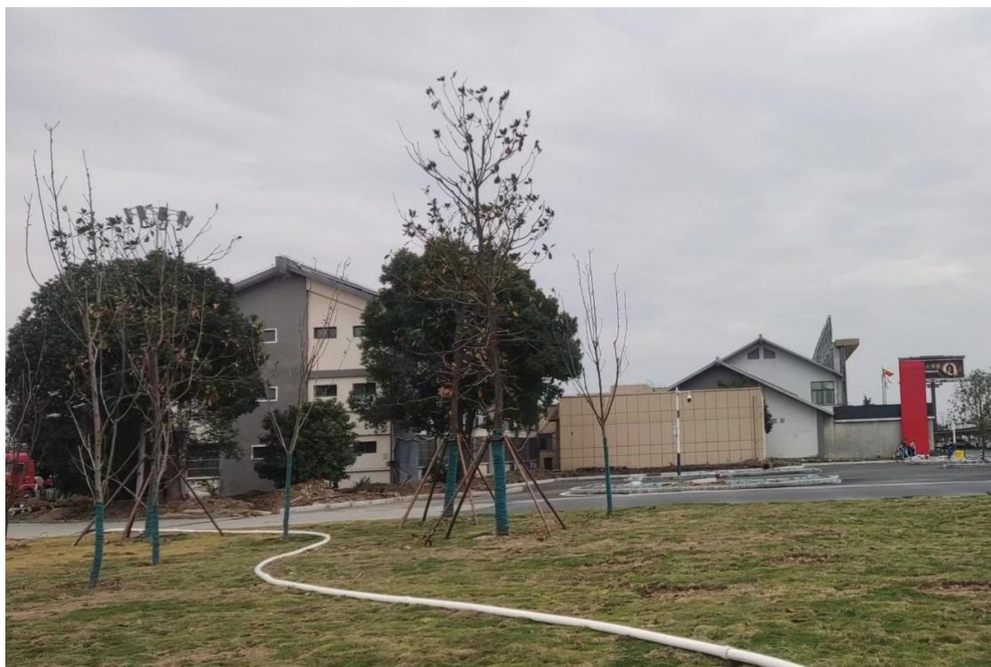
图1 东侧原服务区三层宿舍楼和消防控制室
