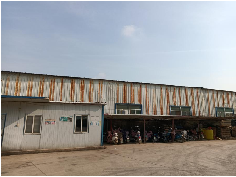
图5 建北侧彩钢板房
