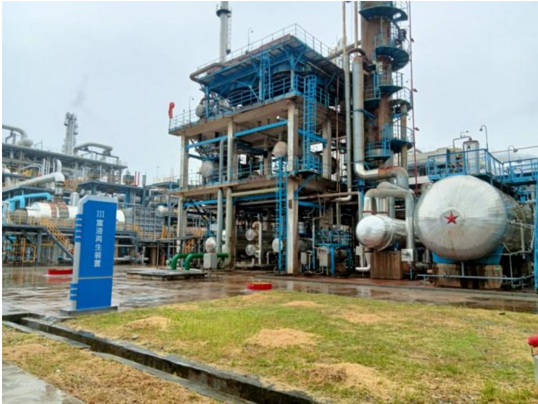
图 11 东南侧III富液再生装置
