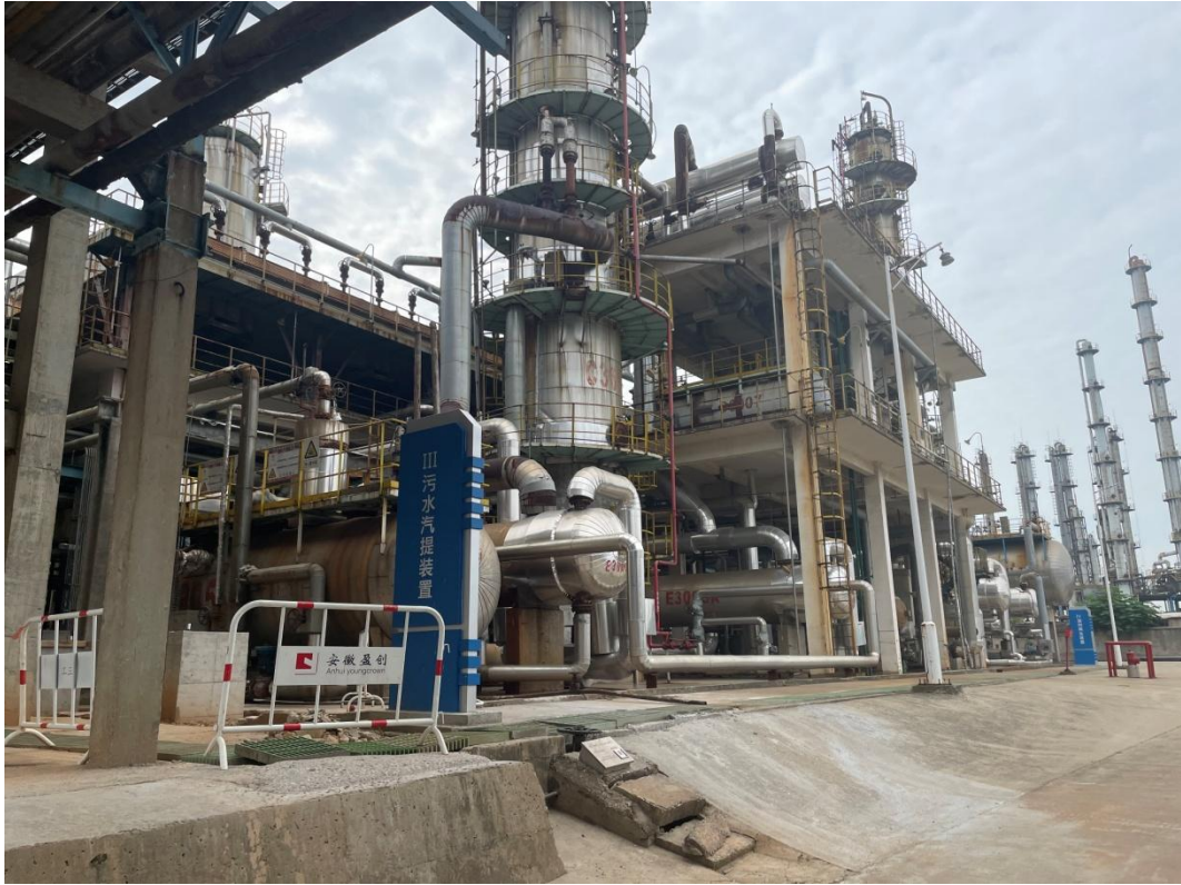
图 5 建北侧 150 吨/时酸性水汽提（Ⅲ）装置
