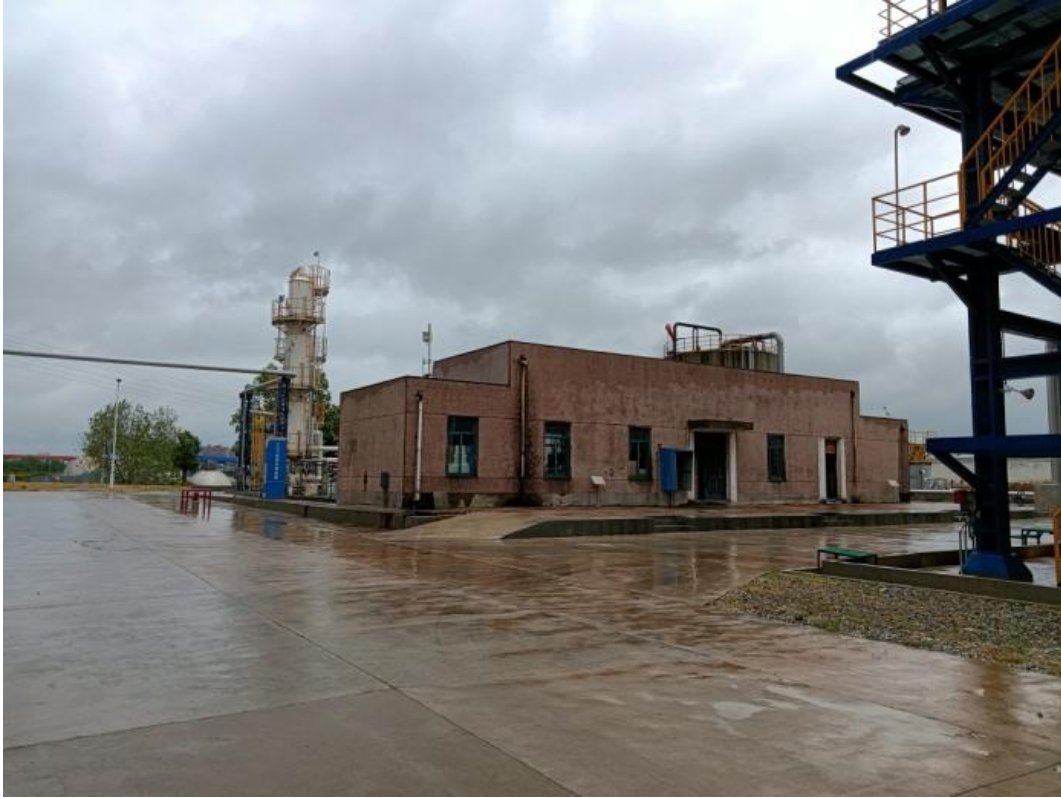
图 9 建西侧 SKBR 碱渣处理装置
