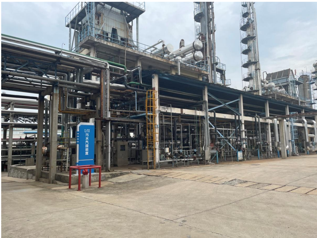
图 6 建北侧为酸性水汽提（Ⅰ、Ⅱ）装置
