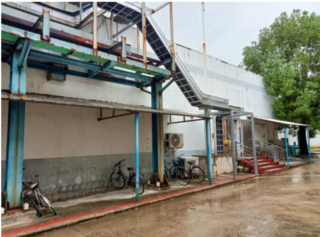
图 12 建东侧机柜间
