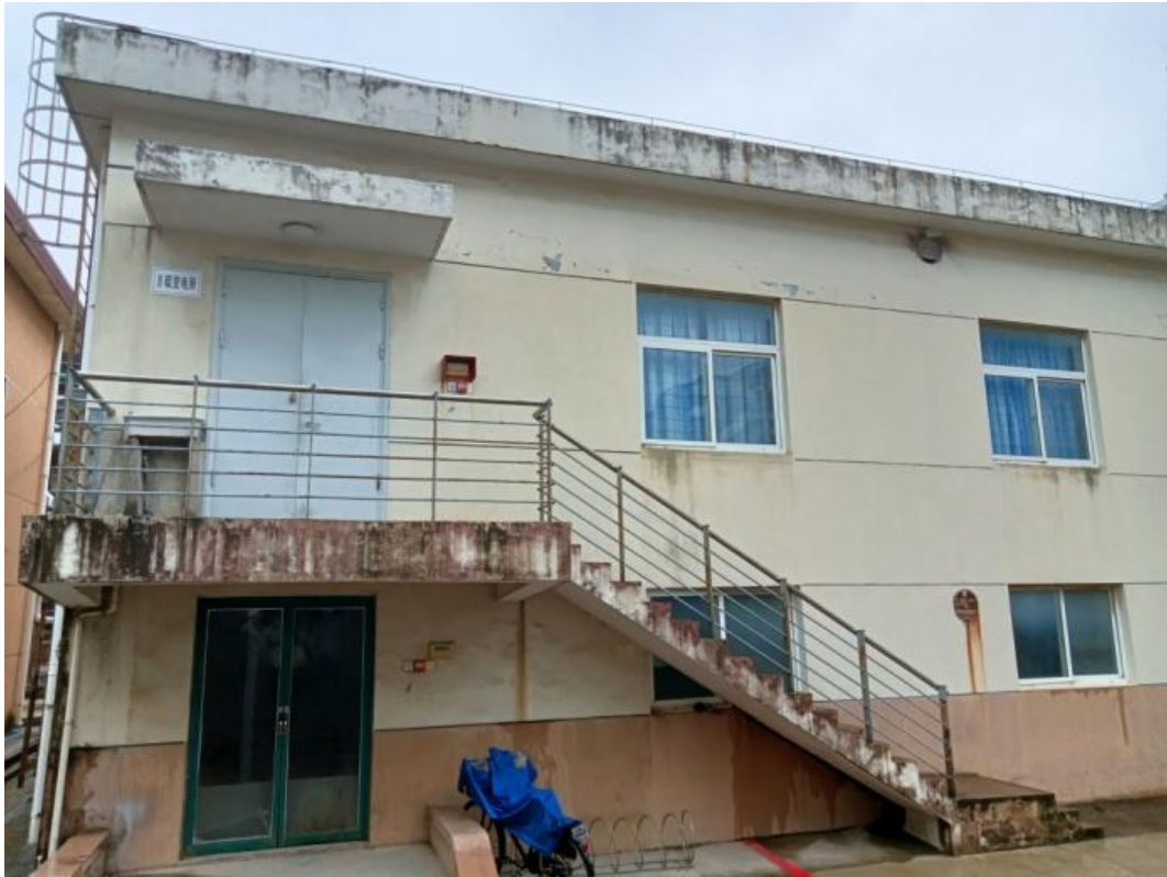
图 13 建东侧 II 硫变电所
