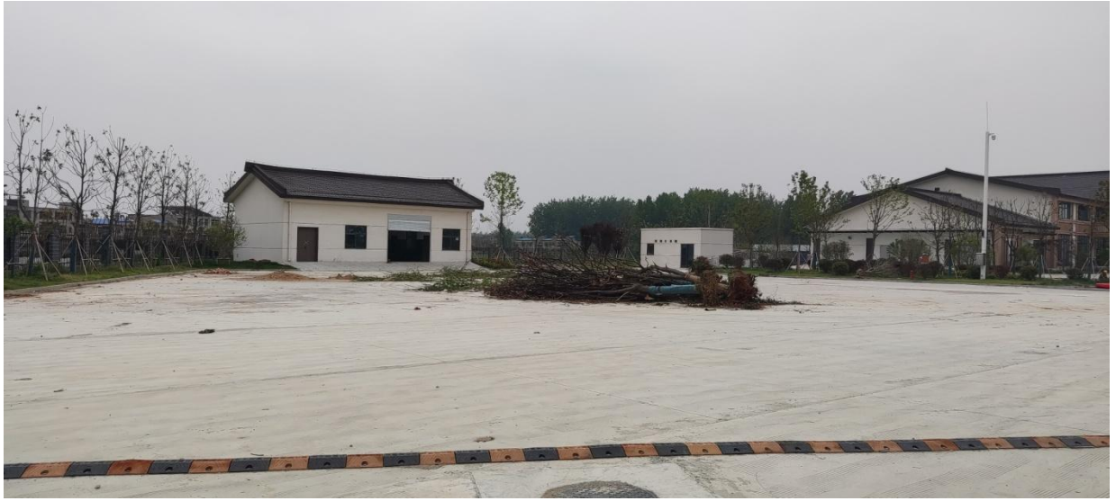
图3 站区东南侧机修间及垃圾站房
