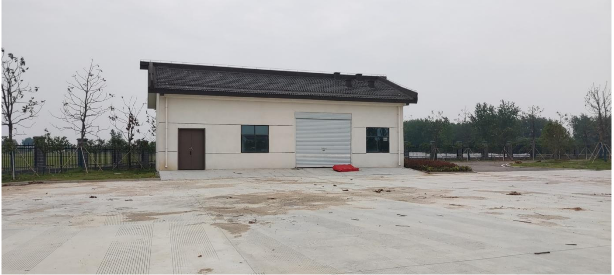
图3 西北侧机修间、农田
