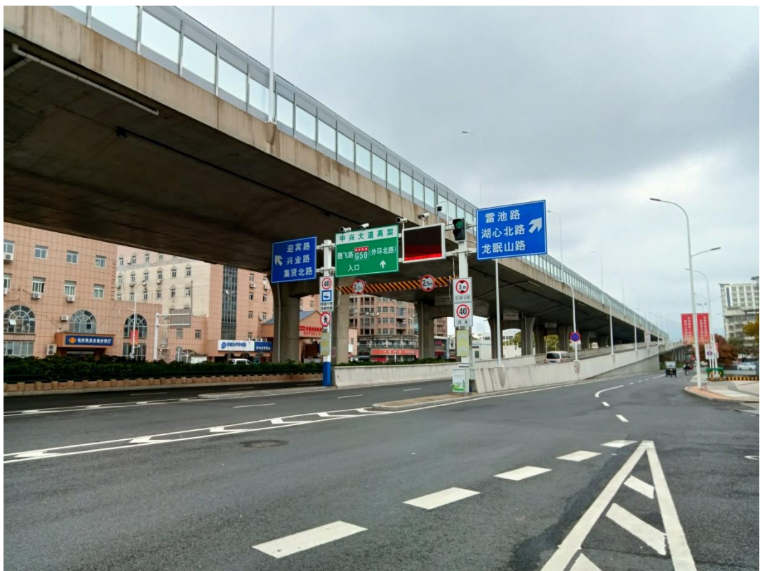
图4 西侧中兴大道
