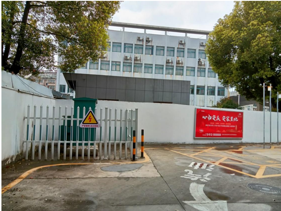
图3 南侧配电房（丙类物品生产厂房）及安庆市经济开发区城市管理局办事厅（二类保护物）
