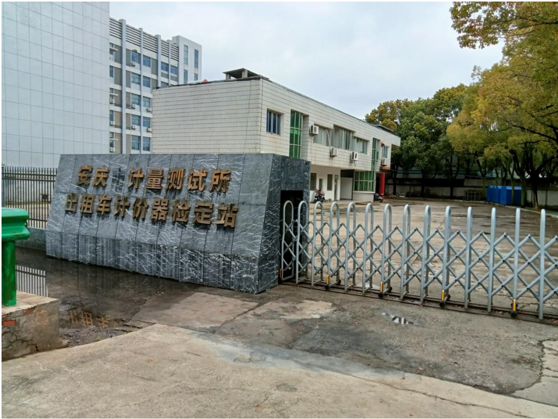
图7 北侧安庆市计量测试所办公楼（二类保护物）
