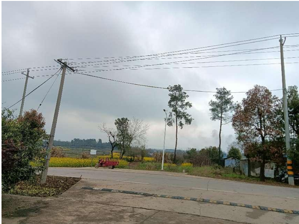
图 2 建南侧凉月公路（次干路）和架空电力线
