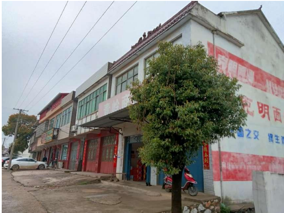
图 5 建西侧民居（三类保护物）和架空电力线
