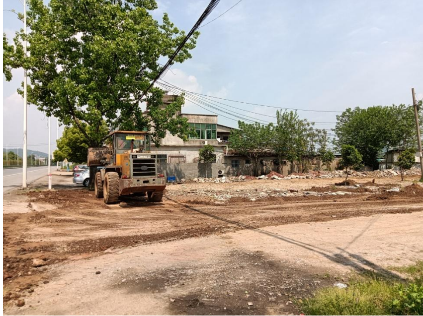
图 1 建东侧民居（三类保护物）和架空电力线
