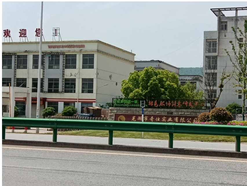
图 4 建北侧 芜铜路（主干路）和芜湖市奇仕实业有限公司（戊类生产厂房）
