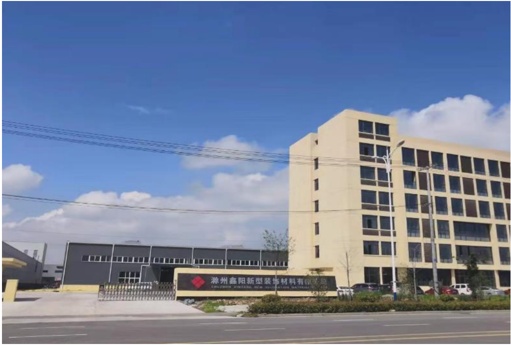
东南侧滁州鑫阳新型装饰材料有限公司
