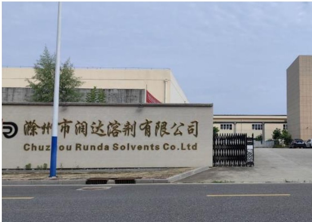
西侧滁州润达溶剂有限公司
