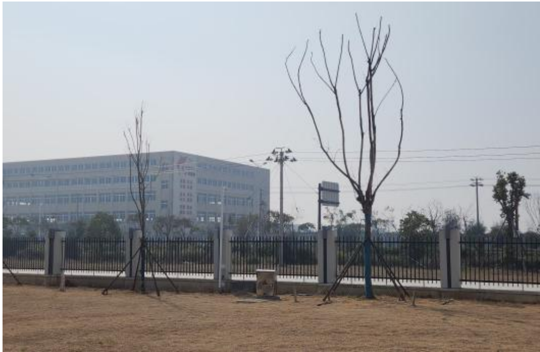
图 5 南侧徐福大道及楼房（已闲置）
