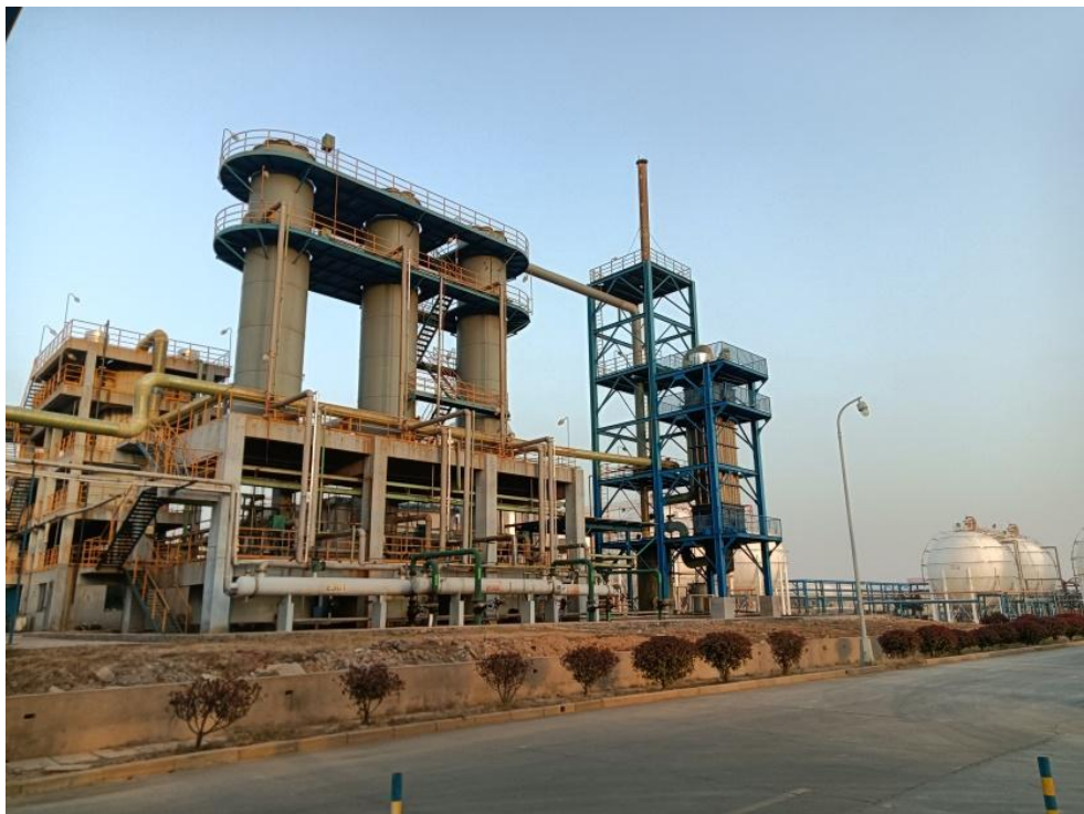
烷基化装置建东南侧为厂内废酸回收装置
