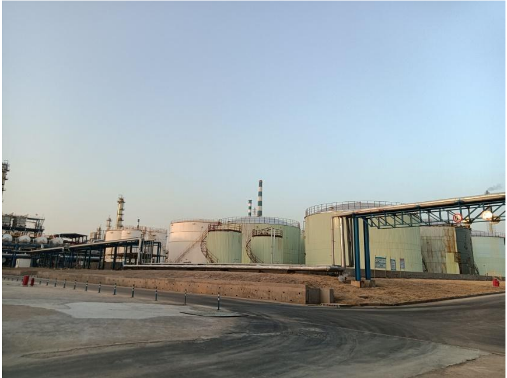
烷基化装置建东侧为厂内异辛烷罐区罐区、酸碱罐区、泵区
