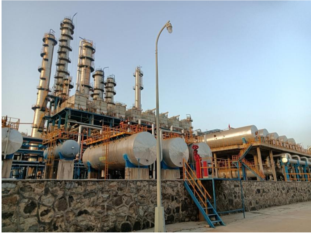
烷基化装置建北侧为厂内碳四综合利用装置
