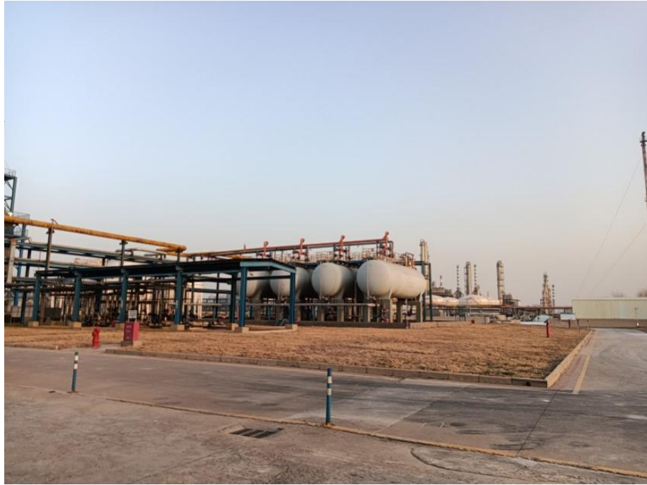
烷基化装置建南侧为厂内正、异丁烷卧罐区及泵棚
