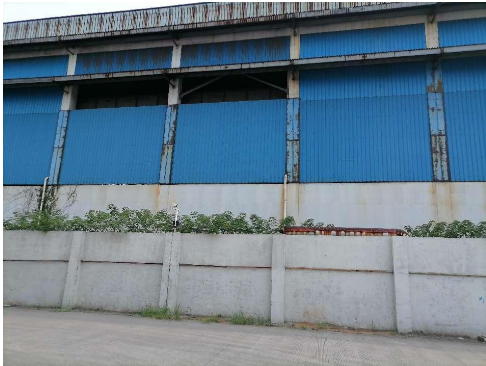
厂区南侧宁波久丰热电有限公司煤棚
