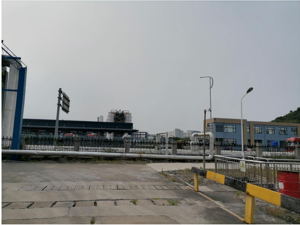
厂区西侧宁波巨化化工科技有限公司液化烃装卸台
