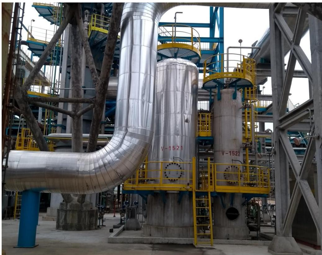
图 2 碱液罐和废水缓冲罐照片
