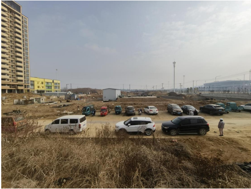
本项目站区东侧
