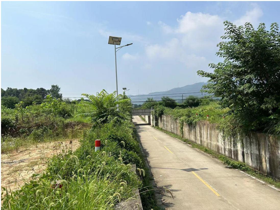
图 2 南侧铁路轨道
