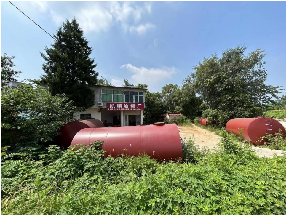
图 1 东侧凯顺油罐厂
