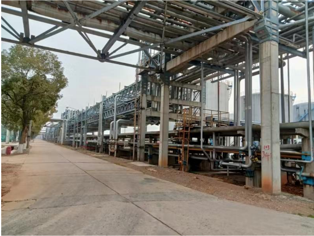
甲醇罐组南侧为 9 罐组
