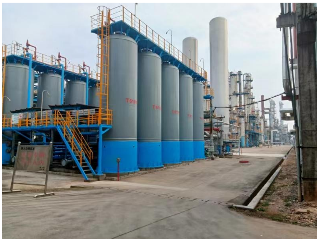
MTBE 装置北侧为蜡油加氢装置
