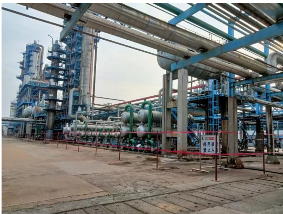
MTBE 装置东侧为催化裂解装置
