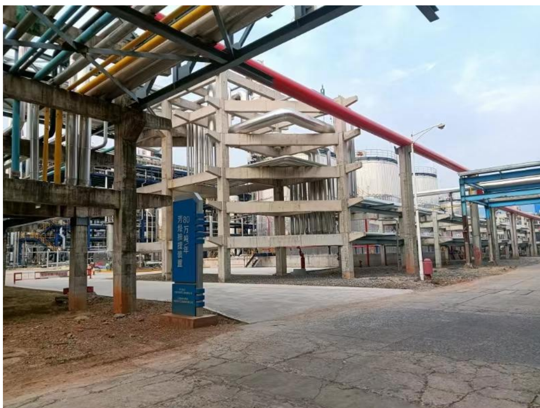
MTBE 装置西侧为芳烃抽提装置
