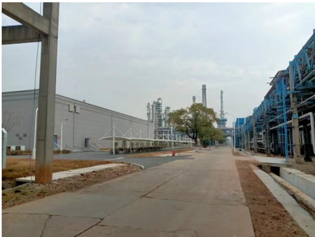
甲醇罐组北侧为炼油 1 区中心控制室 1
