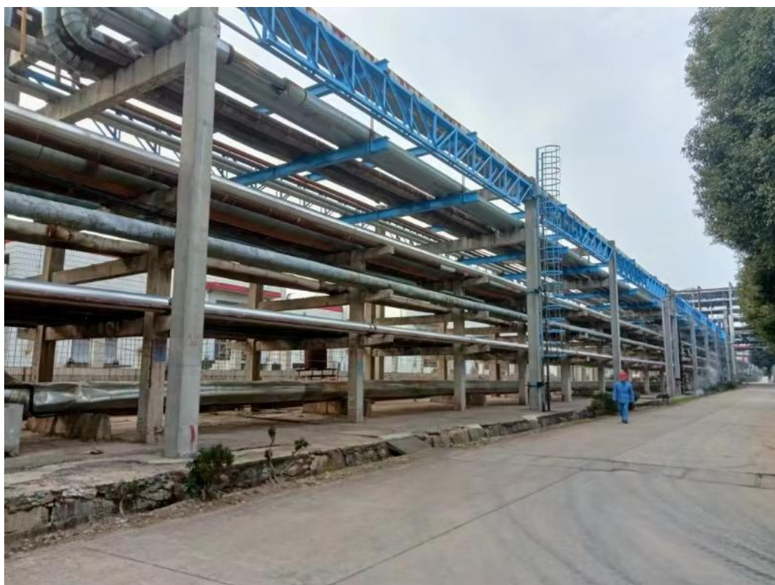
MTBE 装置南侧为变电所
