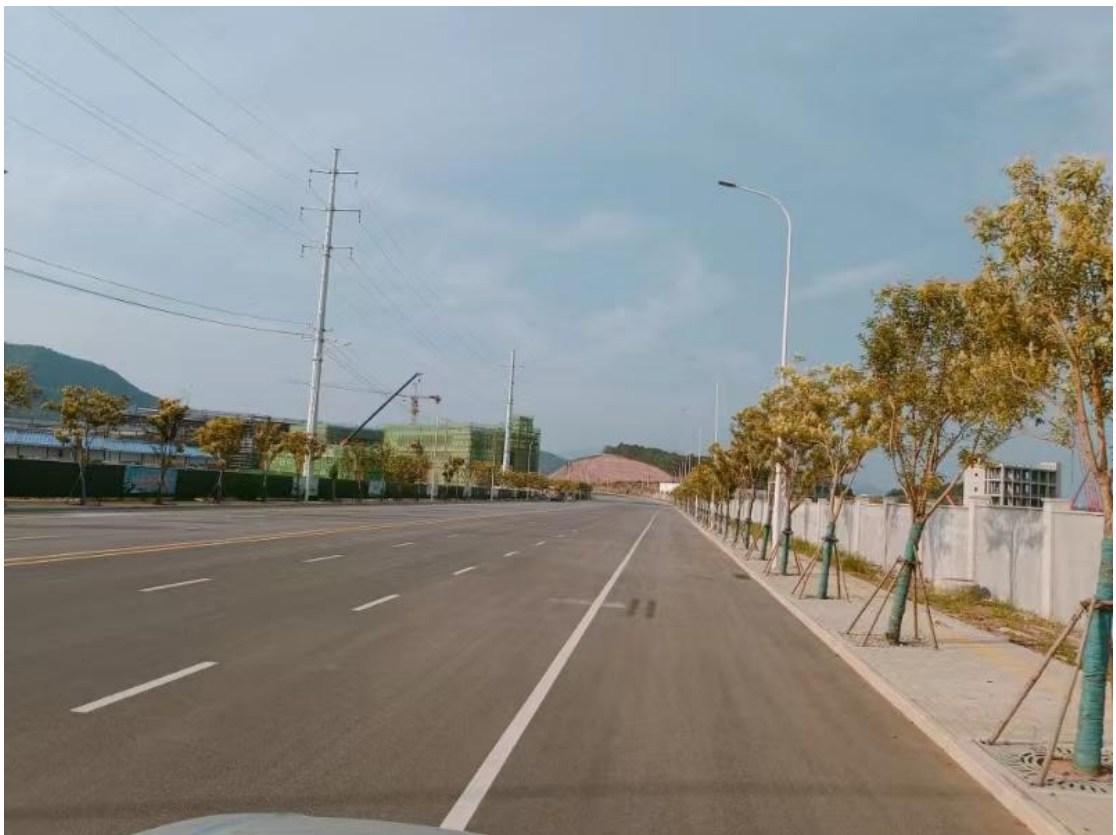
厂区西侧-石门湖路、诚泰新材料
