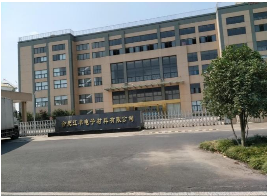
图 1 建东侧为合肥江丰电子材料有限公司
