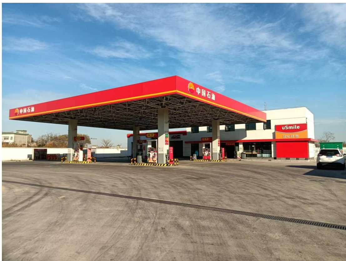
长江南路加油站正面照片
