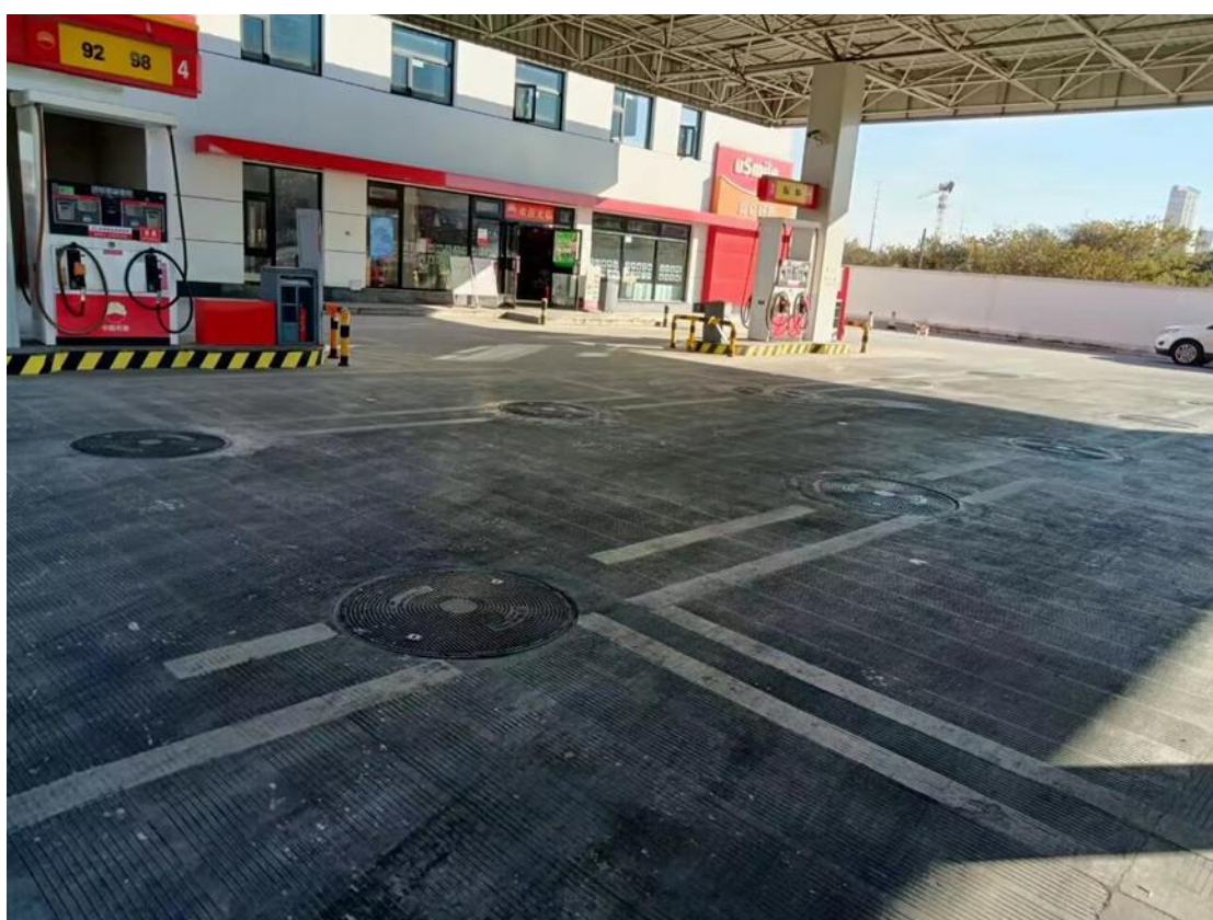
长江南路加油站罐区照片
