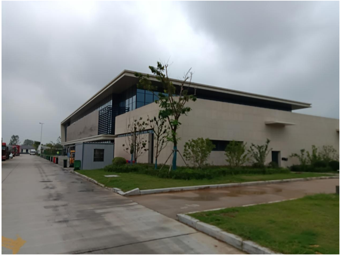
4、东侧罗集北服务区楼
