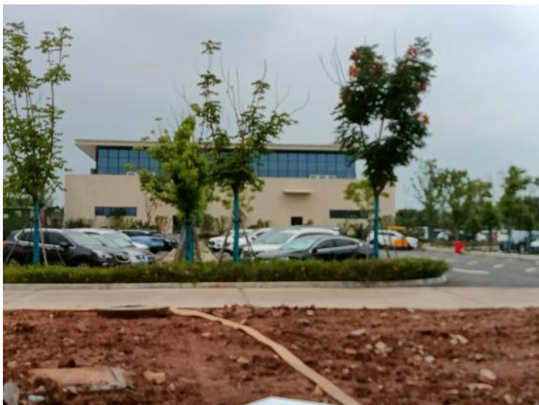
6、西侧为服务区小车停车场
