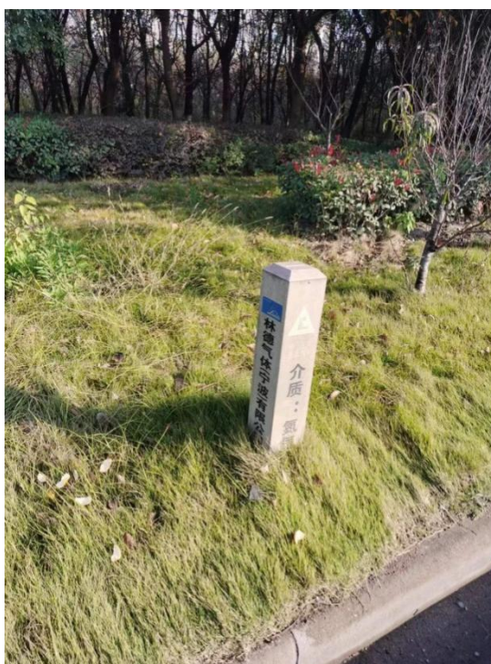
S320 骆霞线北侧 DN300 管线总管标志桩
