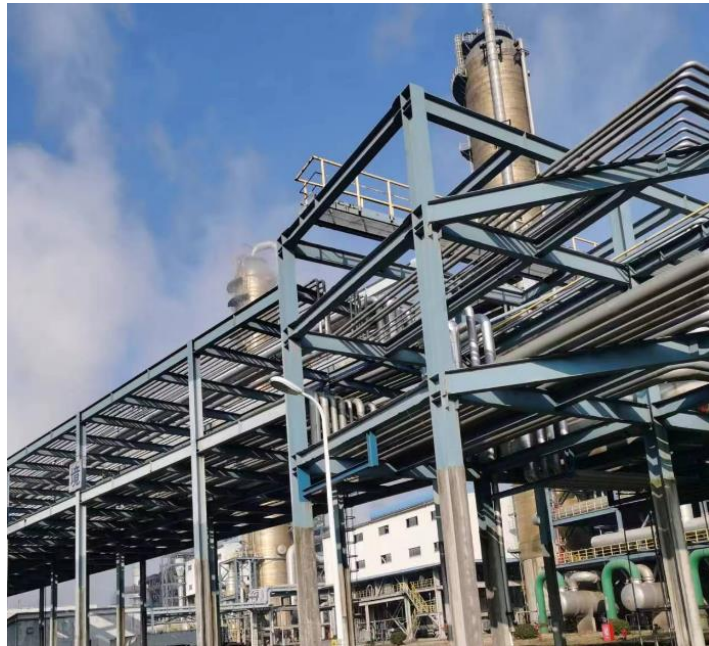
金发新材料管廊支架处（本项目终点）
