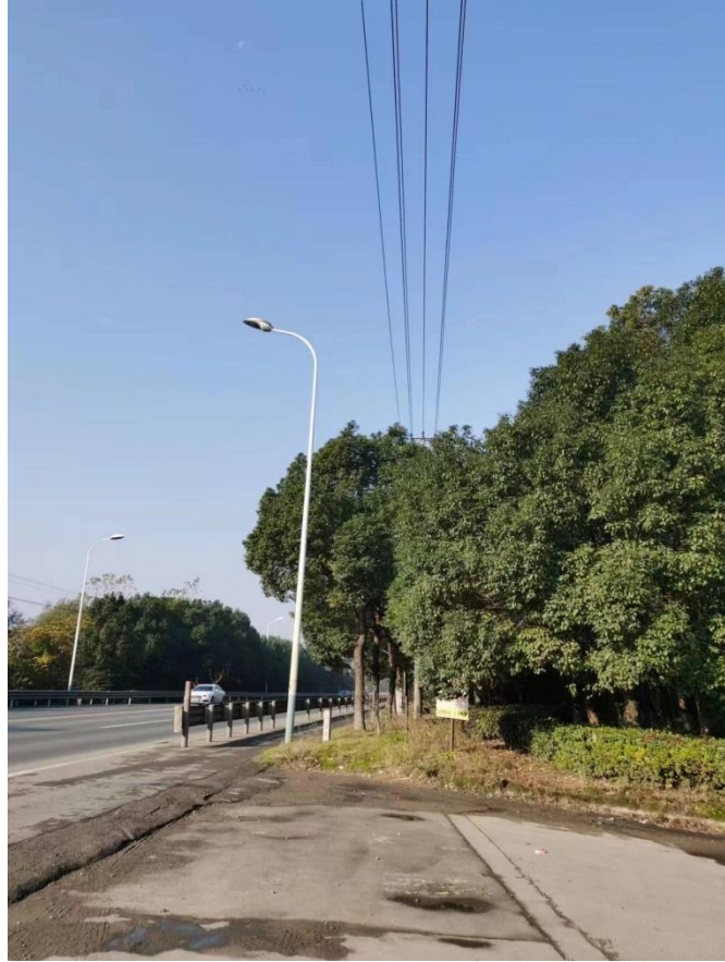
管道起点上方架空电力线
